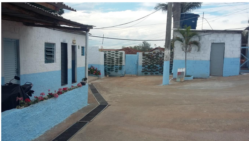
Imagem 9 – Entrada da instituição
